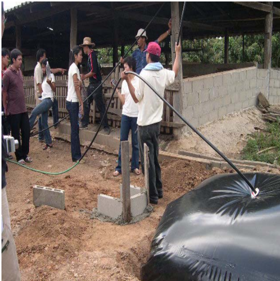
รูปที่ 14 แสดงขั้นตอนการประกอบสายส่งก๊าซ/ติดตั้งขวดปรับแรงดันและดักน้ำ
