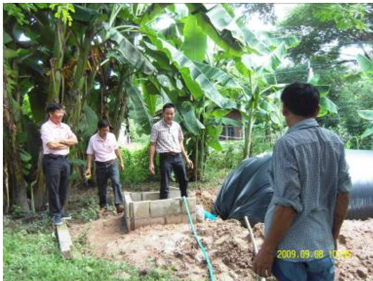
รูปที่ 12 แสดงขั้นตอนการนำถุงหมักหลุม และเติมน้ำให้ท่วมปลายท่อ ด้านในของถุงทั้งสองด้าน
