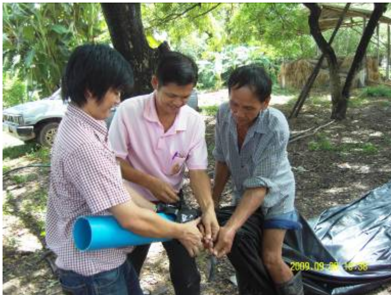
รูปที่ 10 แสดงขั้นตอนการผูกท่อพีวีซีขนาดเส้นผ่านศูนย์กลาง 4 นิ้ว ความยาว 12 เมตร ที่ปลายทั้งสองข้างของถุง แล้วรัดด้วยยางไนโรจจักรยานยนต์
