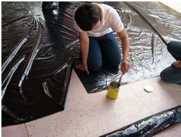
รูปที่ 8 แสดงขั้นตอนการติดพลาสติกเข้าด้วยกันกับกาวอีวีเรป (กาวติดพีวีซี ชนิดร้อน ทรายสิงค์)
