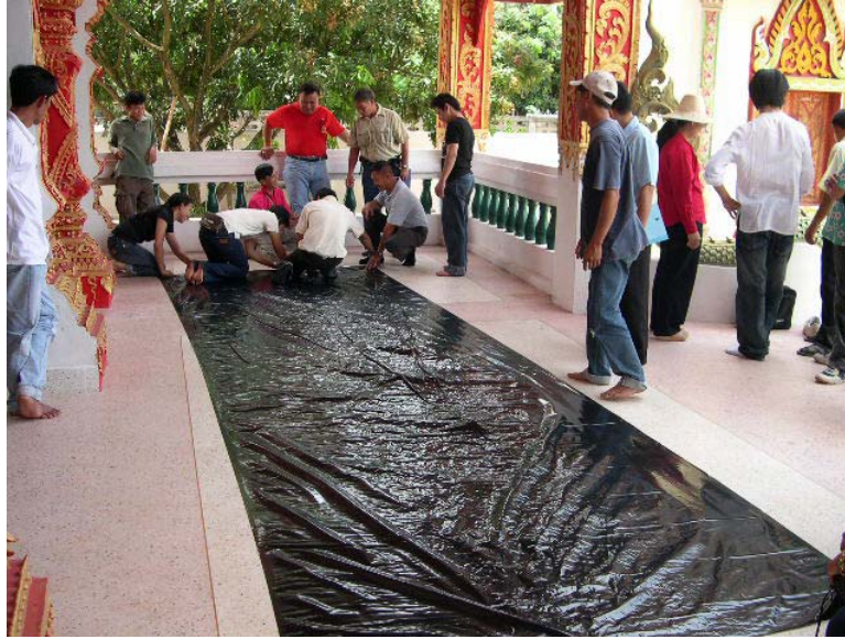
รูปที่ 7 แสดงขั้นตอนการตัดพลาสติกพีวีซีซึ่งขนาดความกว้าง 1.8 เมตร ยาว 6 เมตร จำนวน 3 ชั้น
